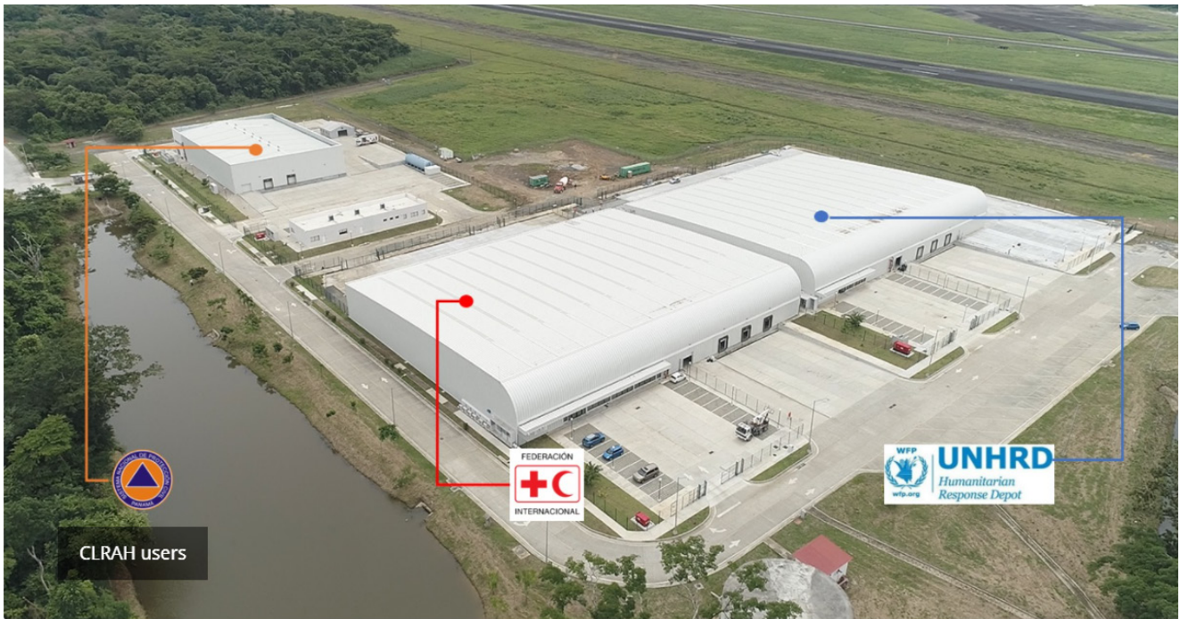
Figura 8 - Instalaciones y usuarios del CLRAH (Fuente: https://www.mingob.gob.pa/hub-humanitario )
